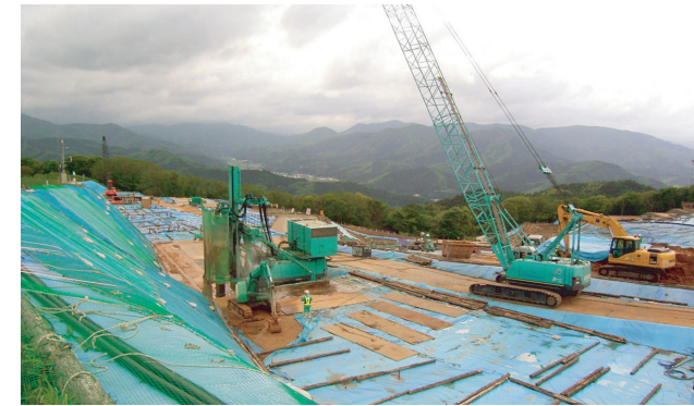
青森県遮水壁工事
