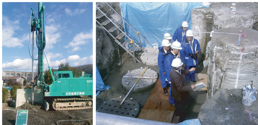
TSC工法 左 施工機械 右 技術審査現場立会会
