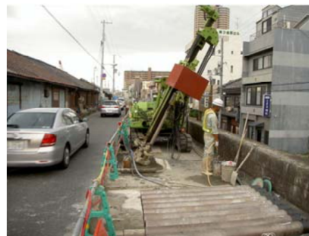
多孔管薬液注入工法 右 薬液注入 左 専用管掘削
