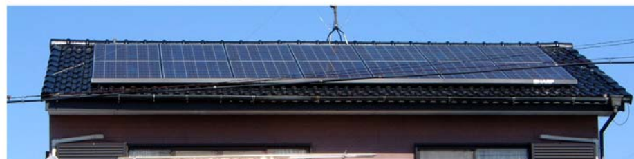
太陽光発電 左上部 発電モジュール 右上部、下 設置状況
