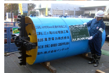
推進工事 上 立て坑内 下 掘進機
