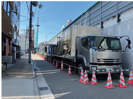
▲側道部の工事全景
