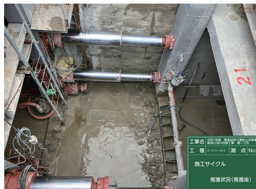
▲マシンテール部の推進状況
