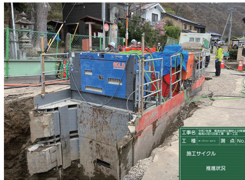
▲マシンフロント部の掘進状況
