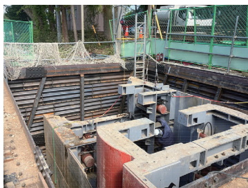
▲マシン解体状況
