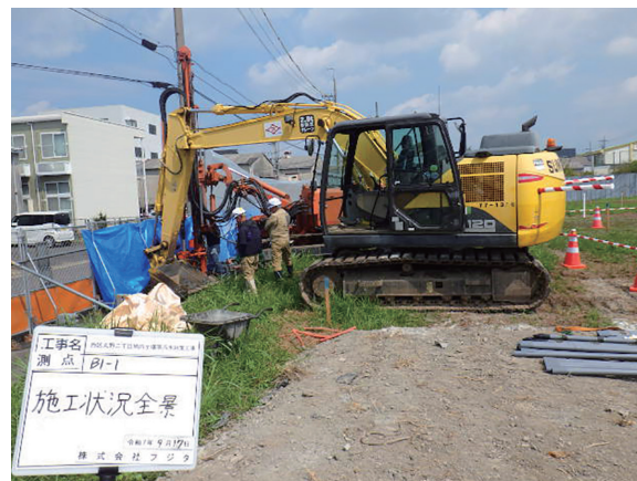
▲施工状況全景
