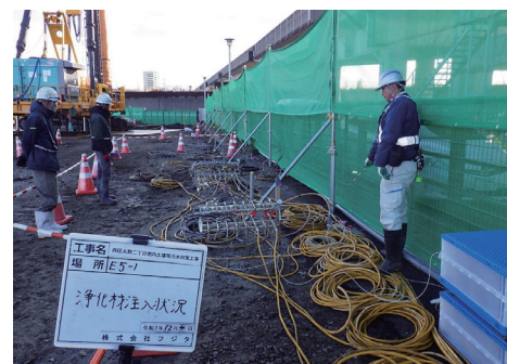
▲浄化材注入状況
