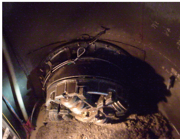
▲掘進機の到達状況
