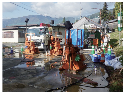
薬液注入工の様子
