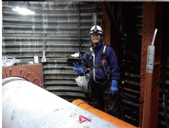
推進工の様子
