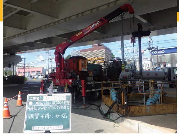
高架下での揚重作業
