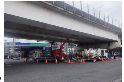
幹線道路上での施工状況
