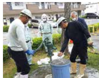
公園井戸設置
