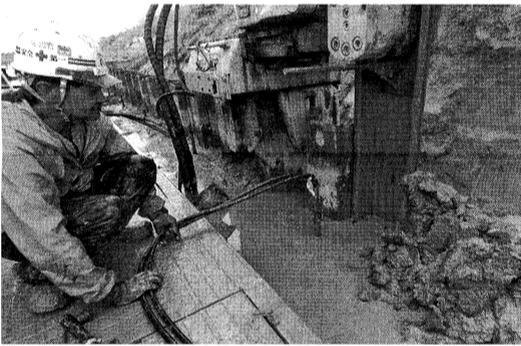
久グラウト材)を引抜きながら同時に充填することで、土留め部材を固化したグラウト材に置き換える工法です。引抜後も周辺地盤にほとんど影響を及ぼすことなく、軟弱地盤や重要構造物に近接した箇所でも安心して撤去ができ、長期にわたり地盤
