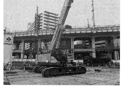
協議により、クレーン移動範囲は両線路高架脚から一八・〇m以内の箇所まで、ブーム延長は一六・五mまでとし、両線路側にブームを向けないように施工をしなければなりませんでした。そこで、クレーンのブーム伸縮が可能であるテレスコピッククレーン (TK-七五〇G) を使用し施工を行いました。
