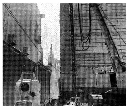
本工事は新築分譲マンションを建築する工事に於ける地中連続壁土留め工を自社開発工法のミニウォール工法により実施しました。
