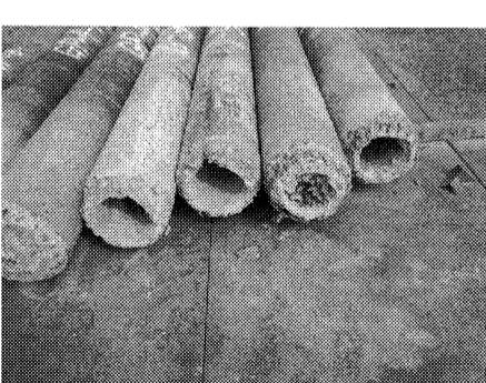
した後、橋脚上部をワイヤーソーで撤去、隣接した工業用水管への影響を考慮して基礎杭は河床より2m以深は残置し、カット杭仕様に製作したケーゼンシングにより杭を所定の位置で切断撤去する工事です。
