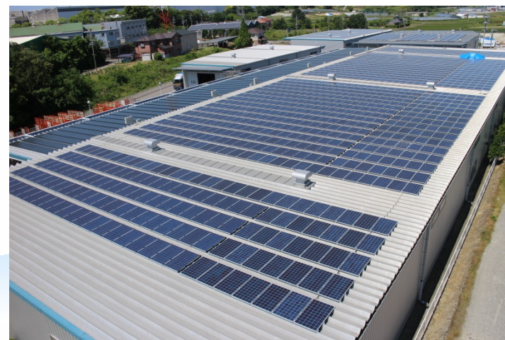
クロケン三好倉庫様第三期増設工事
