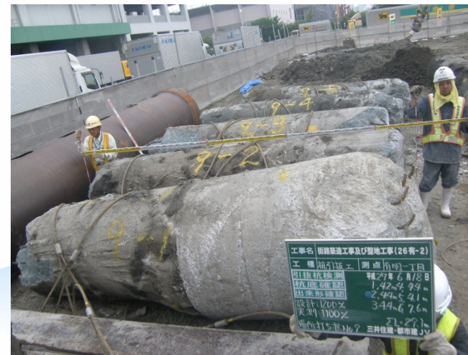
地中埋設杭引抜工事(ヒロワーク Kmighty工法)(東京都)
