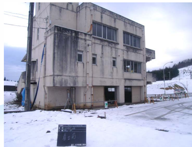
白山運動公園管理棟
