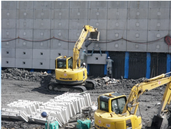
パネル設置状況(沖縄県)
