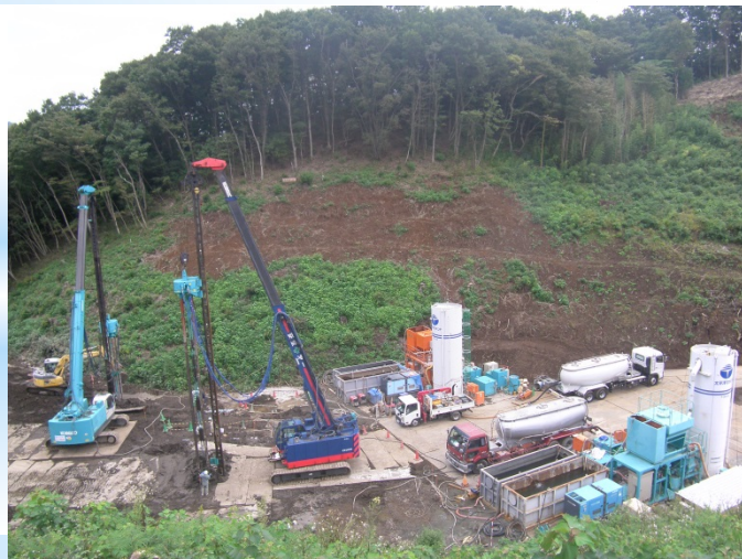
森の里地盤改良工事(浅深四軸工法) (神奈川県)
