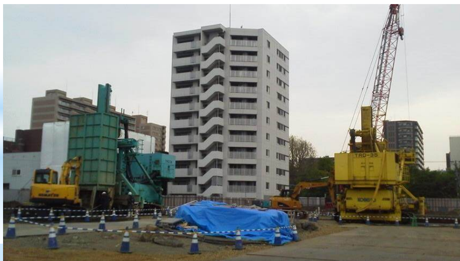
(札幌市内建築現場)
