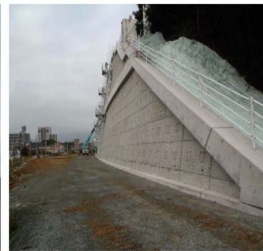
切土補強土工(RBPウォール工法) (福岡県)
