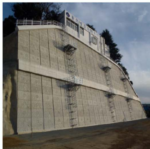
切土補強土工(RBPウォール工法) (福岡県)
