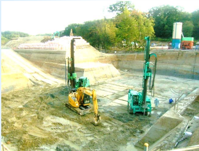
TSC工法(名古屋市) 12t機×2台施工
