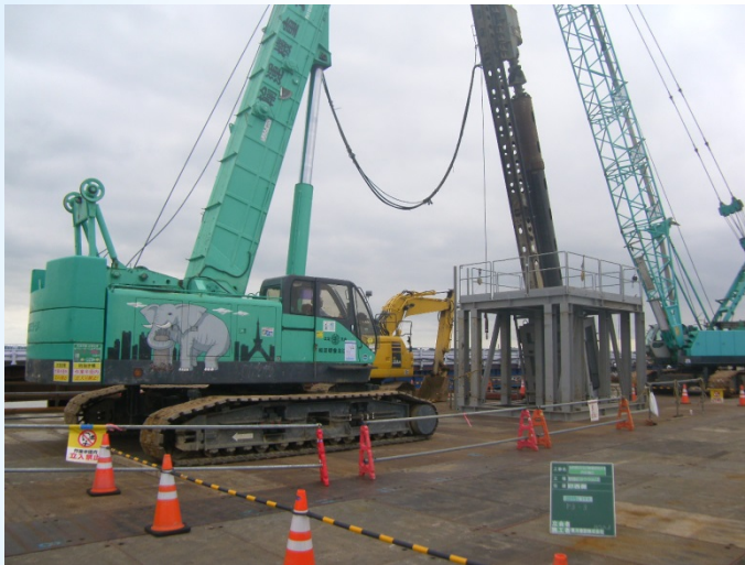
鋼管杭(斜杭)引抜工事(ヒロワーク Kmighty工法)(東京都)
