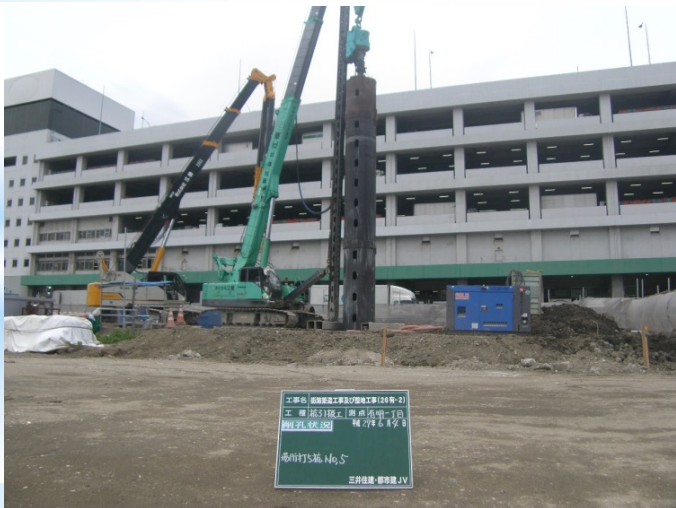
地中埋設杭引抜工事(ヒロワーク Kmighty工法)(東京都)
