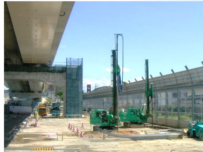
TSC工法(名古屋市) 12t機×2台施工
