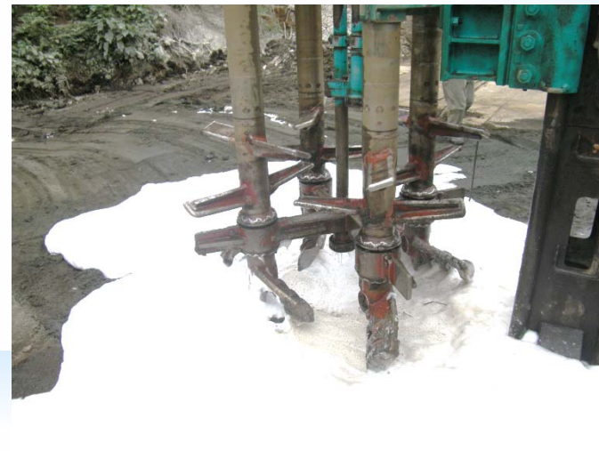
森の里地盤改良工事(浅深四軸工法) (神奈川県)
