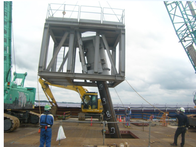
鋼管杭(斜杭)引抜工事(ヒロワーク Kmighty工法)(東京都)
