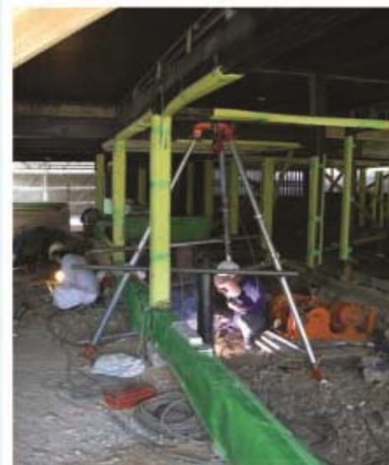
(場内作業状況)
