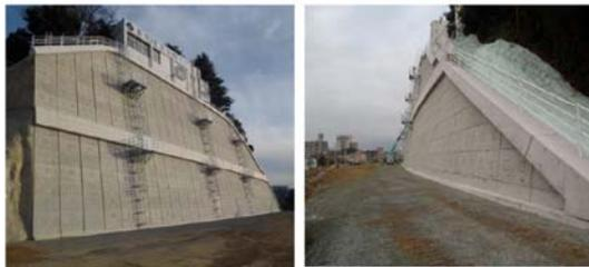
切土補強土工(RBPウォール工法) (福岡県)
