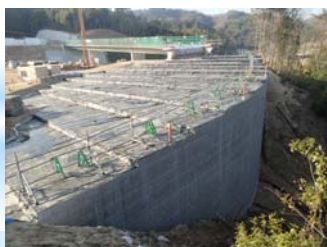
気泡混合軽量盛土工事(FCB工法) (大阪府)
