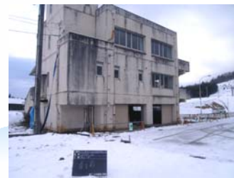
白山運動公園管理棟
