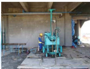
柱状ドレーン工法（三重県）
