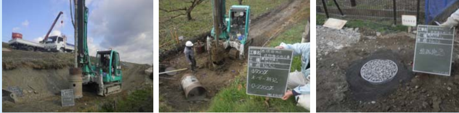
堤脚防護工事(ウエルドレーン工法) (和歌山県)
