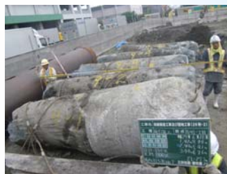
地中埋設杭引抜工事(ヒロワーク Kmighty工法)(東京都)
