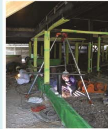
(場内作業状況)
