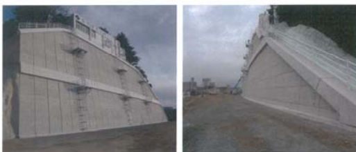
切土補強土工(N-SPCI工法) (福岡県)
