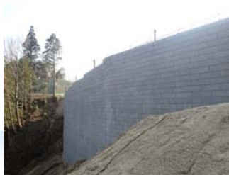
気泡混合軽量盛土工事(FCB工法) (大阪府)
