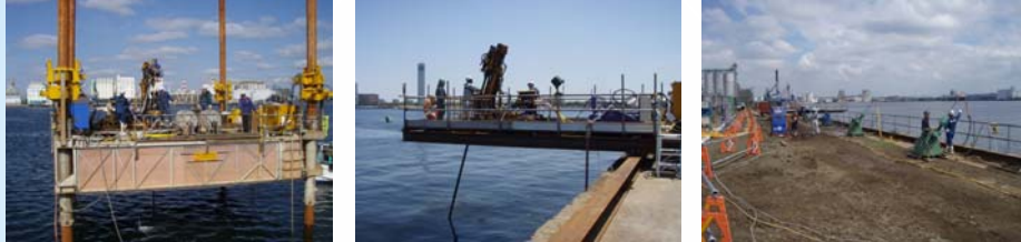
多孔管注入工法（成田国際空港 石油ターミナル構内）
