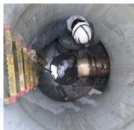
静岡県内初低耐荷力 R60急曲線推進工法
