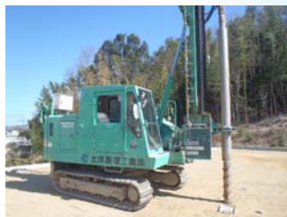
ピュアパイル工法
