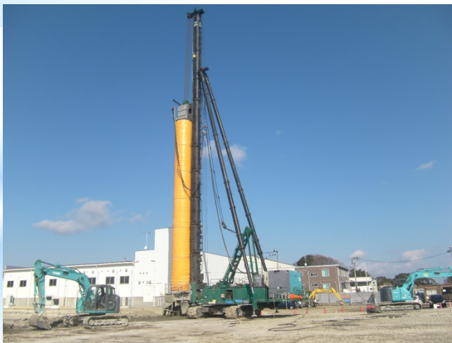
CCC工法(宮城県塩釜市)
