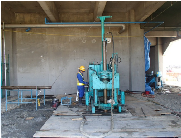
柱状ドレーン工法(三重県)
