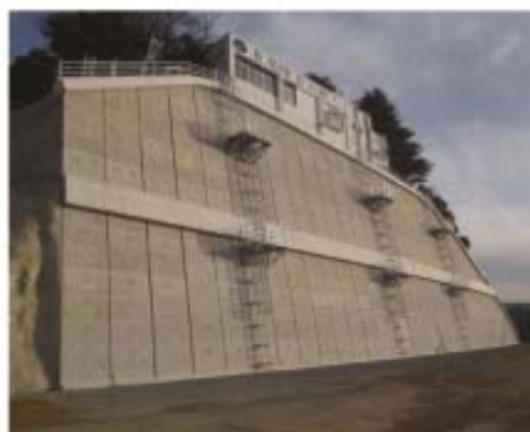
切土補強土工(N-SPC工法) (福岡県)
