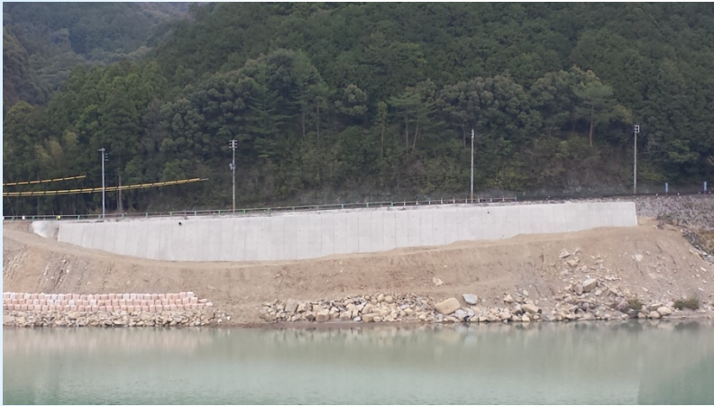
紀伊半島豪雨災害復旧工事(N-SPC工法)(三重県)
