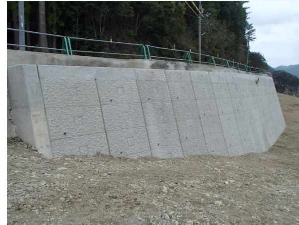
紀伊半島豪雨災害復旧工事(N-SPC工法)(三重県)
