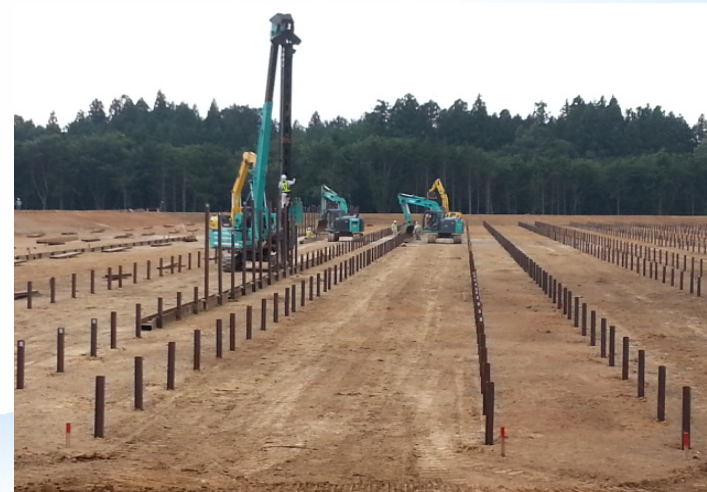
ソーラーパネル基礎杭工事(福島県)
