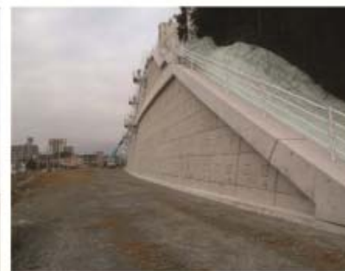
切土補強土工(N-SPC工法) (福岡県)
