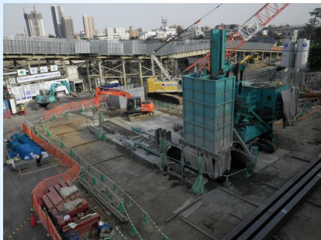
(東京外環自動車道)
