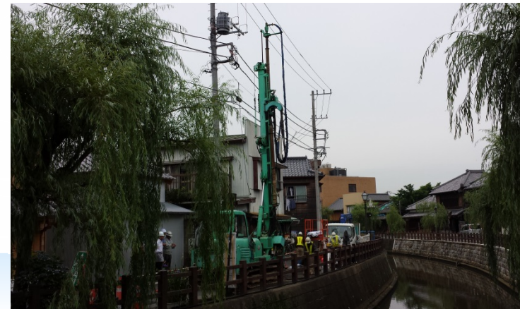
OHODレーン工法(茨城県)
