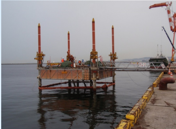
多孔管注入工法(和歌山県)
