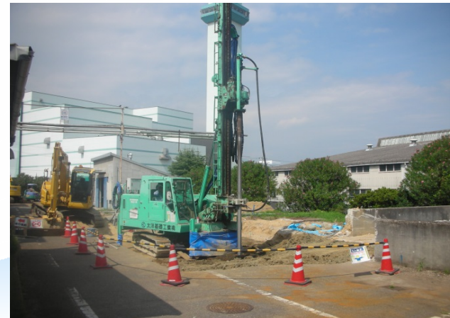
鉄粉気泡混合工法(広島県)
