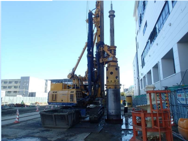
地中障害物撤去工 (大阪市旭区)
