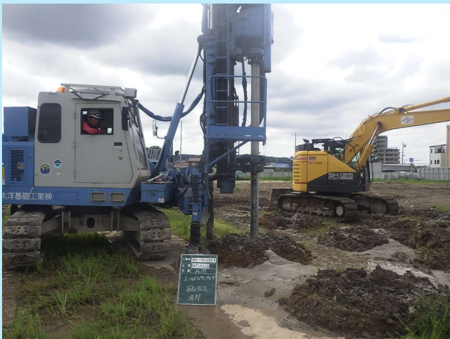
春日井市熊野町 (スラリー式攪拌工)
