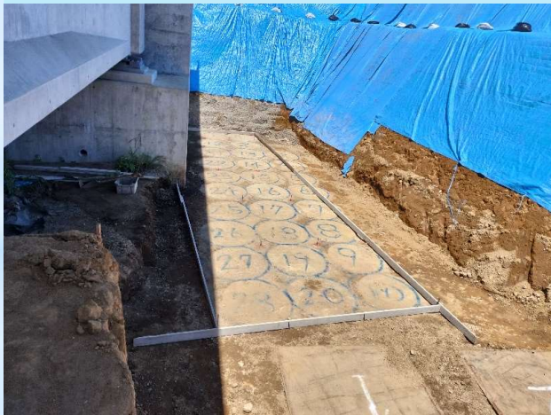
スラリー攪拌工 (沼津市岡宮)
