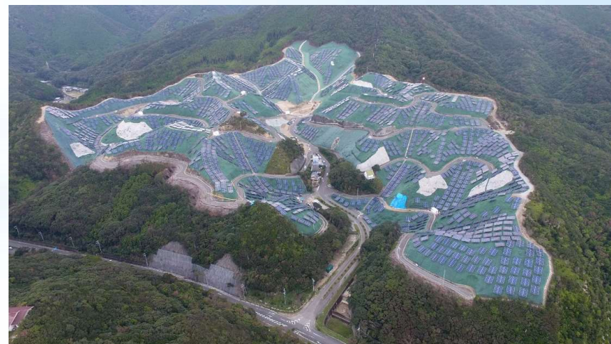
旭すさみメガソーラー(9.2MW)
