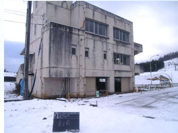
白山運動公園管理棟
