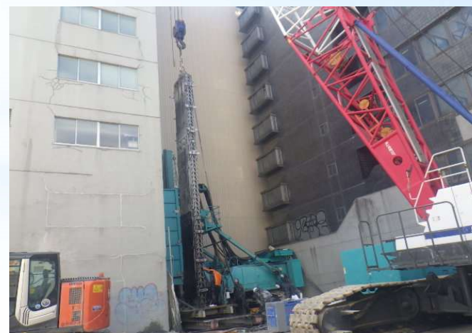
(大阪市中心区建築現場)
