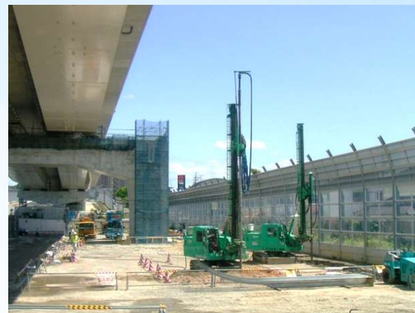
12t機×2台施工
