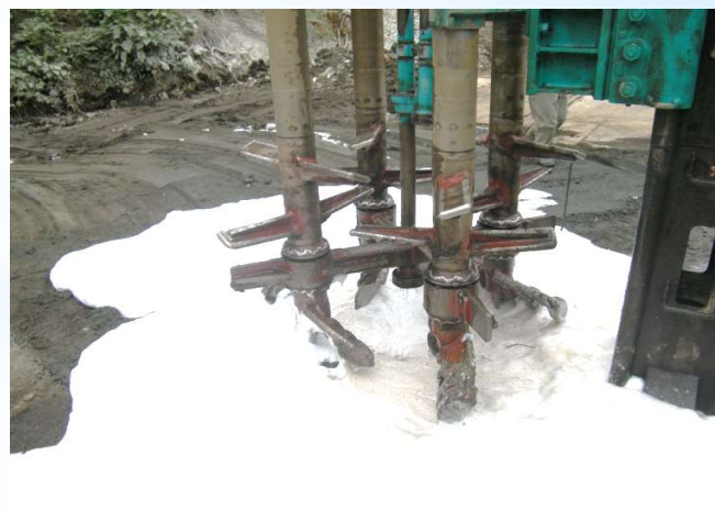
森の里地盤改良工事(浅深四軸工法) (神奈川県)
