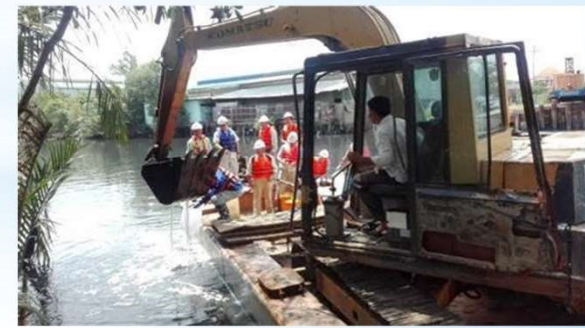
ビンチャン区タンフット村土砂採取状況
