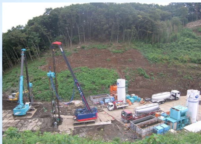
森の里地盤改良工事(浅深四軸工法) (神奈川県)
