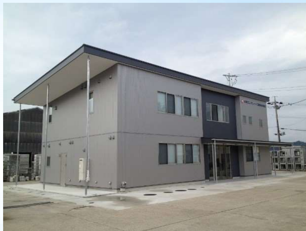
T社様新事務所建設工事
